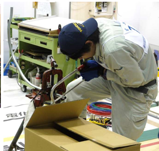
▼ 金属配管を加工する門間選手
